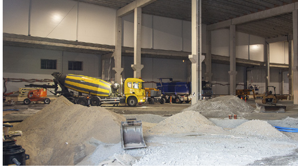
Une vingtaine de personnes en moyenne ont travaillé sur le chantier de l'usine de transmissions, mais leur nombre a beaucoup varié en fonction de l'avancement des travaux.
